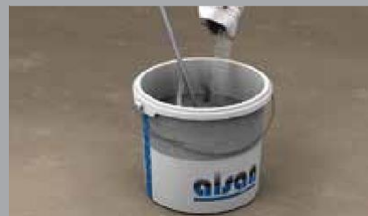
Při pomalu běžící míchačce přidejte katalyzátor (podle tabulky pro směšování, teploty a doby zpracování) a 2 min. míchejte. (Malá množství lze rozmíchat i ručně)
